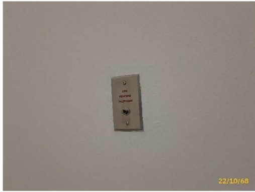
ช่องเสียบบอร์ดโทรศัพท์ฉุกเฉิน
