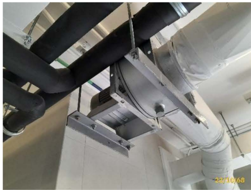
พัดลมดูดอากาศและระบบปรับอากาศ
