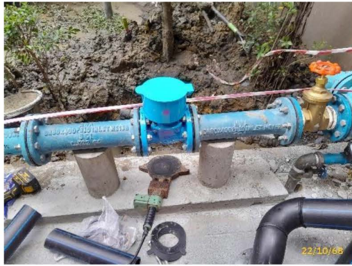
จุดเชื่อมต่อระบบน้ำใช้
